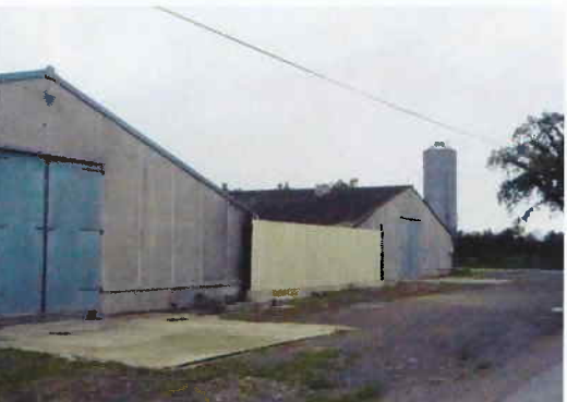
Aménagement entre 2 bâtiments à ventilation dynamique limitant la dispersion horizontale des odeurs (crédit ITAVI)
