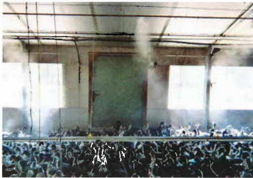
Brumisation haute pression de produits masquants/neutralisants (crédit ITAVI)
